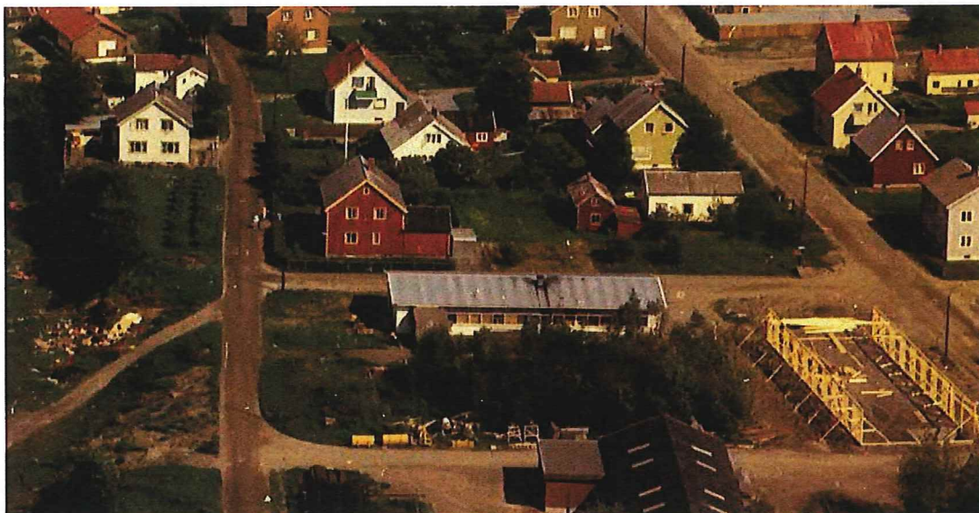
Langnes og Bakkan i ferd med å bygge i Hanskemakergata i 1969. Foto utlånt av Verdals kommune.
